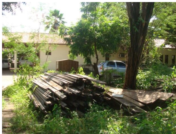
Figura 05 - Vista posterior da edificação sede do IBAMA Fonte: Acervo pessoal (2012)
